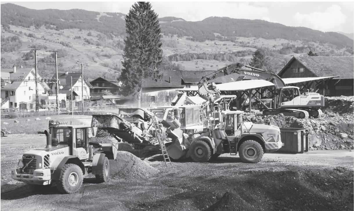
*Aufbereiten des Abbruchmaterials mit Mobilbrecher zu Recyclingkies 0–80 mm.
