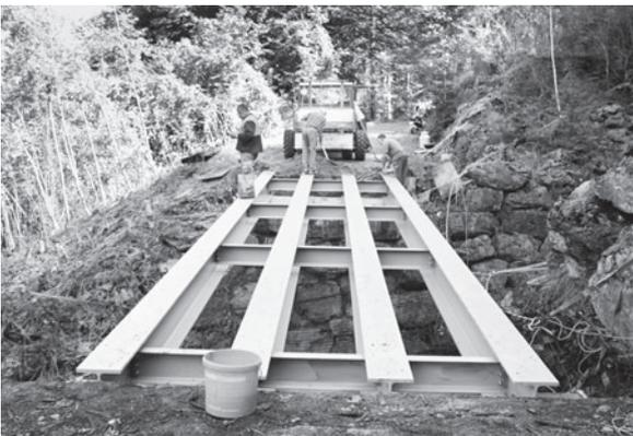
*Einbau der neuen Eisenträger und Erstellung Brückenfundament*
