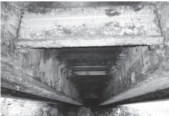
*Stark angerostete Stahlträger und Querverbindungen*
