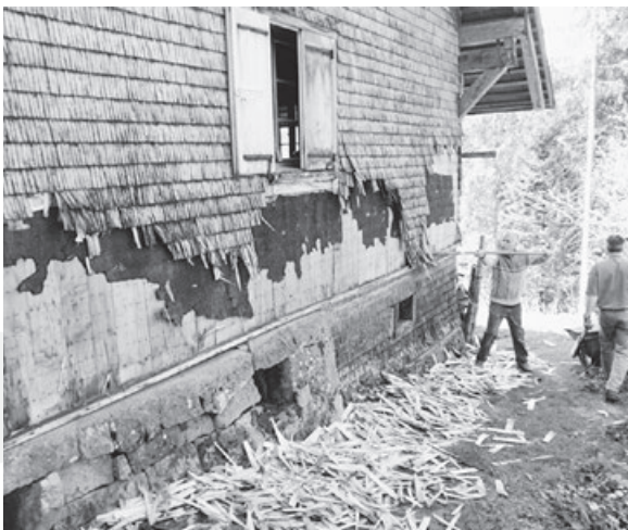
Entfernen des alten, morschen Schindelschirms
