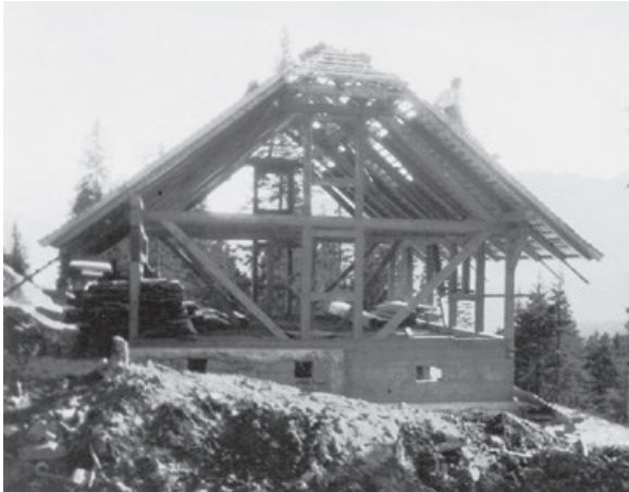
Die Unterkunftshütte ist aufgerichtet, die zweite Dachhälfte schon gut zur Hälfte mit Schindeln eingedeckt.
