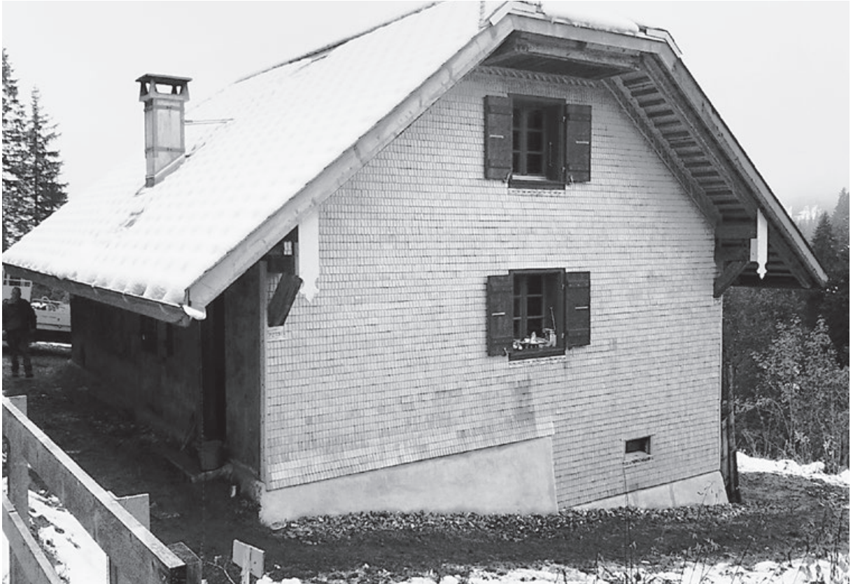
Sattelseitige Ansicht: Entwässerungs-Rollierung, verputzte Mauer, neuer Schindelschirm, neue Fenster, neue Dachkännel, neues Dach
