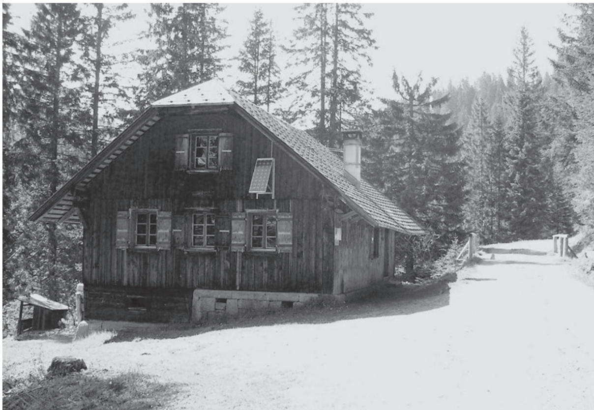
Zwirchi Forsthütte an der Strasse zum Sattelpass, hinten links unten das WC-Häuschen
