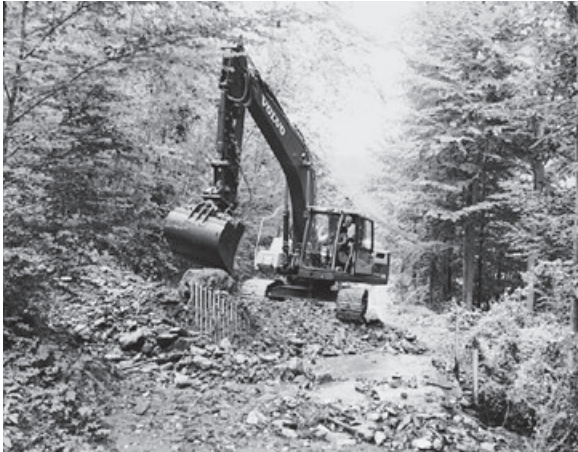
Bärfallenstrasse Aufräumarbeiten, Auflad und Abfuhr von 1'000 m 3 Schwemmmaterial
