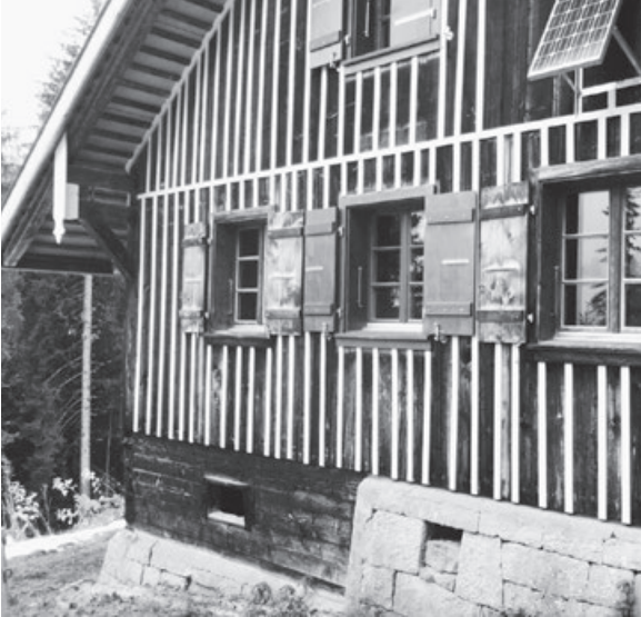
Mit Deckleisten sind die offenen Fassadenschaltungsstellen bald geschützt. In der Mitte und oben je ein neues Fenster.
