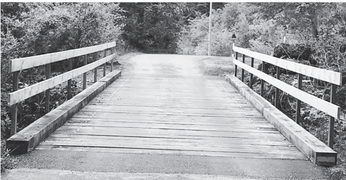
Bärfallenstrasse Fertig sanierte Brücke inkl. Belagsanschlüsse
