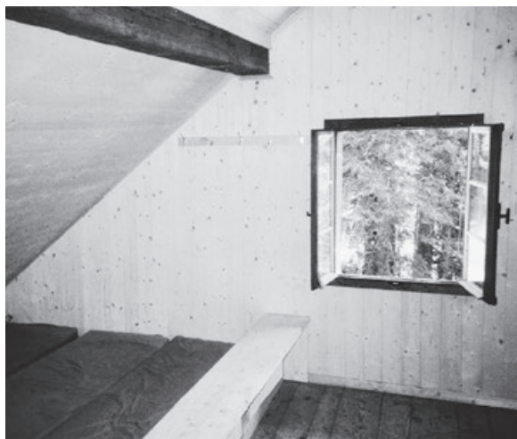
Isoliert, mit neuem Täfer eingeschlagen, neue Schlafstellen für 12 Personen eingerichtet
