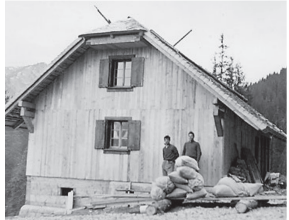
Die ziemlich fertige Unterkunftshütte im Zwirchi (Diese sechs Fotos aus der Bauzeit und etwas später stammen aus dem AWL in Sarnen).
