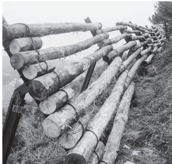
Kastanienholz montiert bei Stahl-Holzwerken
