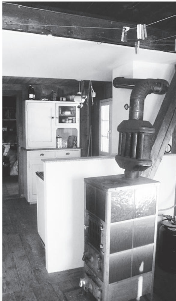
Neuer Kochherd: Halbhohe Rückwand, Brandschutzdecke (erweitert) und Kamin gestrichen
