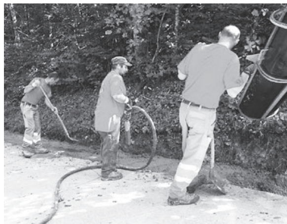
Kapellwaldstrasse Einbau des Betons durch Peter, Huby und Santiago
