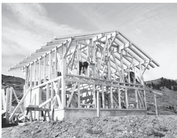
Loohüttli im Rohbau 2009
