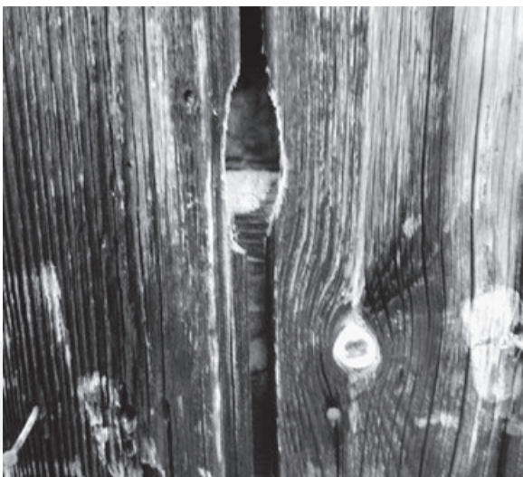
Die Schalung ist aus Nut und Kamm auseinander getrocknet. Ein Nager hat sich Einlass verschafft, die Isolation beschädigt und sich eingenistet.
