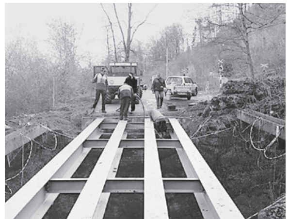
Bärfallenstrasse Einbau der neuen Eisenträger und Erstellung Brückenfundament
