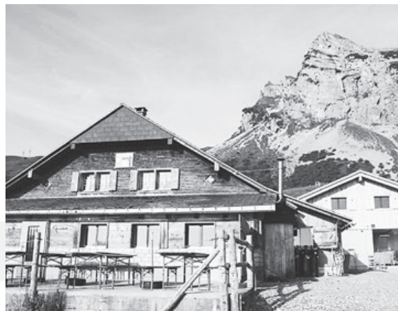
Um- und Anbau Lengegghütte 2014
