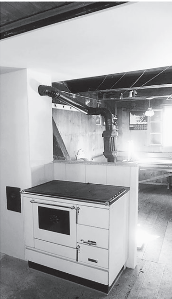
Neuer Kochherd: Halbhohe Rückwand, Brandschutzdecke (erweitert) und Kamin gestrichen
