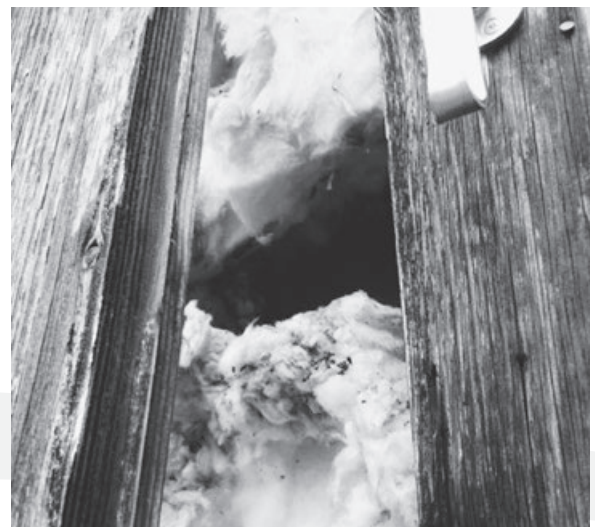
Die Schalung ist aus Nut und Kamm auseinander getrocknet. Ein Nager hat sich Einlass verschafft, die Isolation beschädigt und sich eingenistet.
