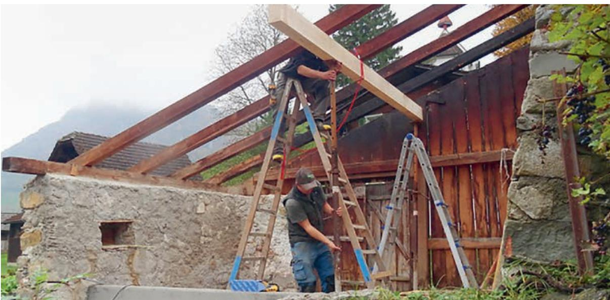
Die eingebaute Mittelpfette verhindert das Durchhängen des Pultdaches. Die Sockelmauer für die spätere Holzwand ist bereits erstellt.
