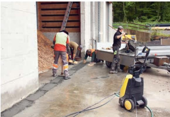
*Zubetonieren der bestehenden Bodenschienen*
