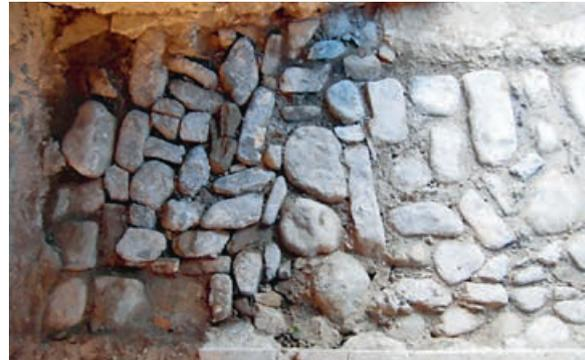
Bei der Bauuntersuchung kam ein massiver Bollensteinboden zum Vorschein, dieser konnte belassen werden und dient als Fundament für die Sockelmauer.
