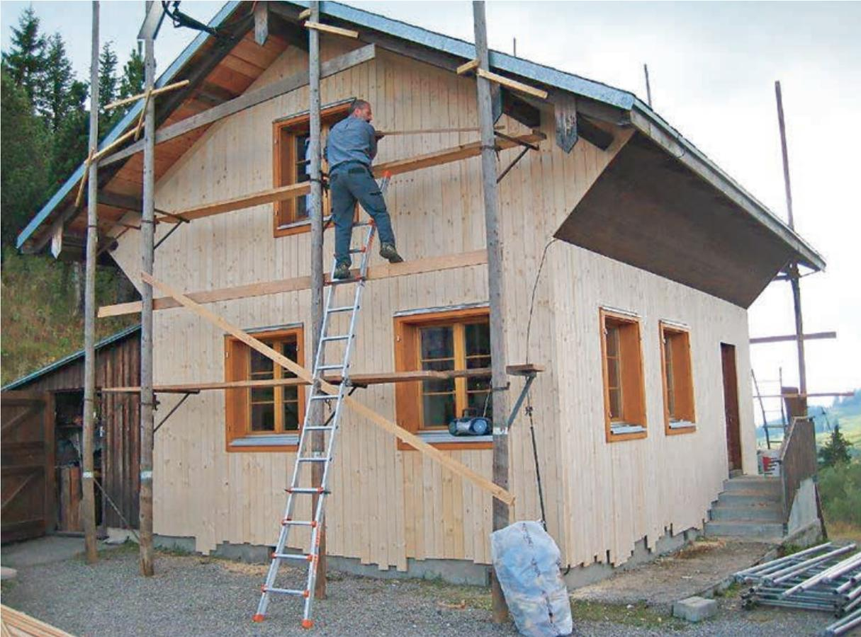
*Renovation 2010, Schindelschirm wird ersetzt durch eine Längsschalung*
