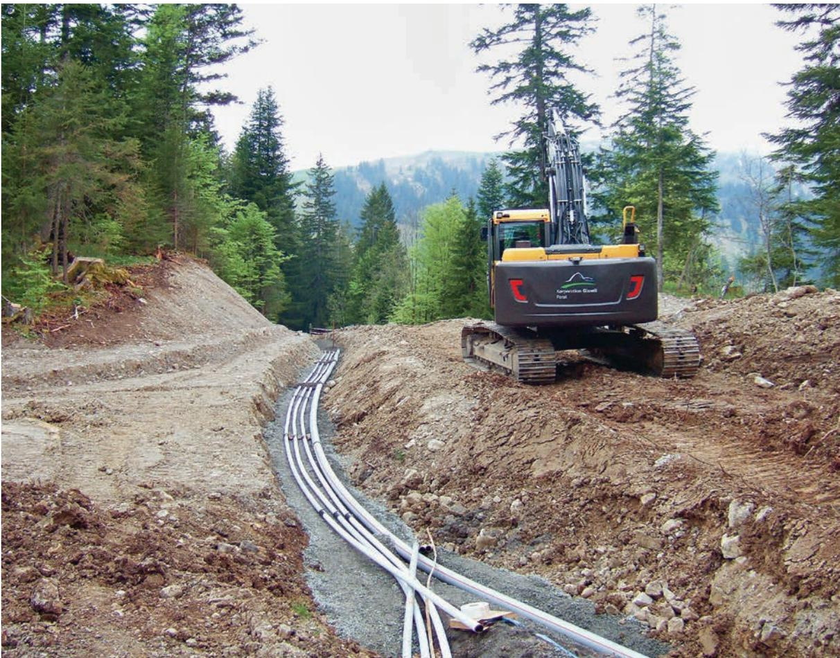
*Verlegen der Werkleitungen in den neuen Strassenabschnitt*
