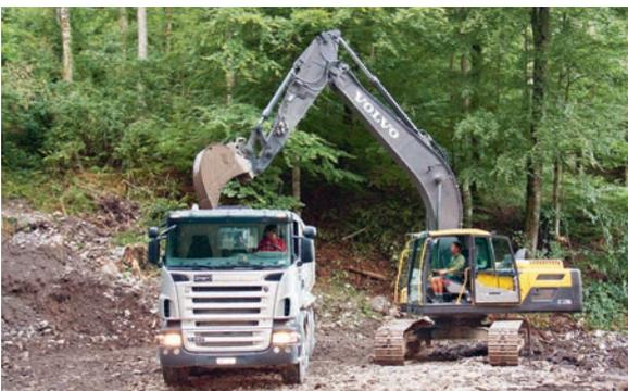
Aufgrund der diversen Unwetter wurden die Sammler oberhalb der Brünigstrasse mit Schwemmmaterial aufgefüllt. Dieses Schwemmmaterial wurde im Auftrag der zentras (Verkehr und Infrastruktur Zentralschweiz) verladen und für die Betonherstellung durch die Fanger AG abgeholt.
