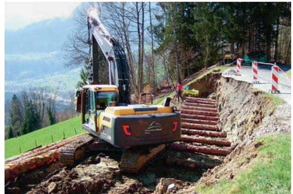
Für die Gemeinde Giswil konnte der Forstbetrieb an der Stein-Schlad-Strasse im Bereich Brunegg einen Holzkasten zur talseitigen Stützung der Strasse einbauen. Dazu wurden total 32 m<sup>3</sup> Rundholz verbaut. Gleichzeitig wurde im Bereich der Baustelle das talseitige Bankett neu aufgebaut.
