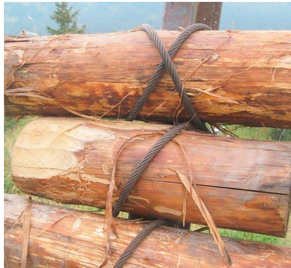
Montiertes Stahlseil Durchmesser 12 mm bei einem Holz-Stahlwerk
