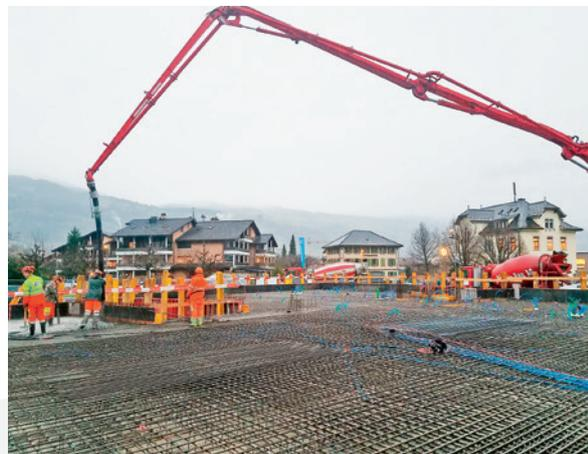
*Betonieren der Decke mit Betonpumpe*
