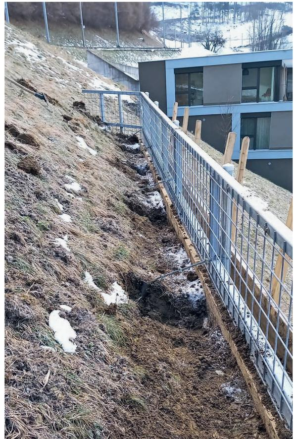
Ökogitter der Firma Ribbert AG vor der Befüllung mit Sand, Holz und Steinen.
