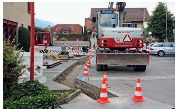
*Einfüllen und verdichten des Grabens nach erfolgtem Einbau der Fernwärmeleitung Brünigstrasse 40/42*
