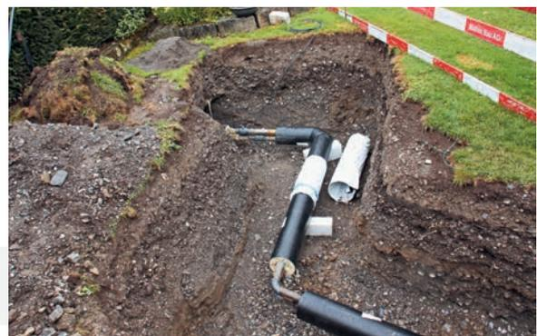
*Fortführung der Fernwärmeleitung ab Rosenweg Richtung Einstellhalle Mattenweg. Einbau Stahl Doppelrohr DN 65 mit Dehnschenkel*
